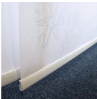
Detail spodní lišty posuvného panelu
